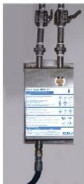
Beta Foam 2000 SC es un equipo especial para aplicar detergente en forma de espuma. Para su aplicación se requiere de un sistema centralizado de detergente. Cuenta con una válvula de ajuste el cual permite ajustar la calidad de la espuma desde húmeda hasta seca.
